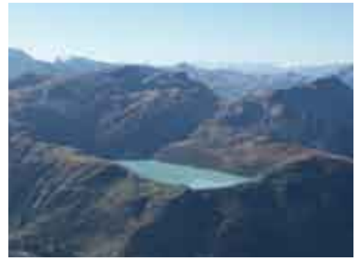
Barrage de la Girotte
